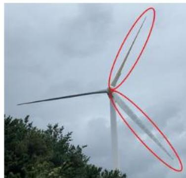
16号風車：ブレード2枚破損
