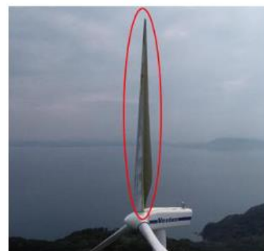
7号風車:ブレード1枚破損
