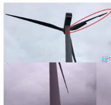
13号風車:ブレード1枚破損
