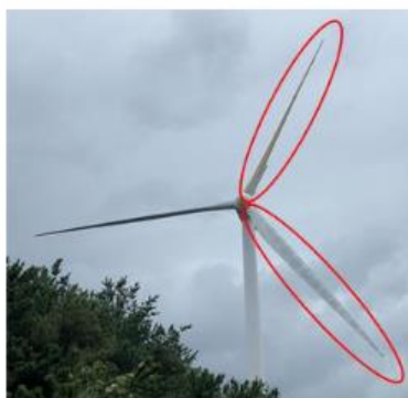
16号風車:ブレード2枚破損
