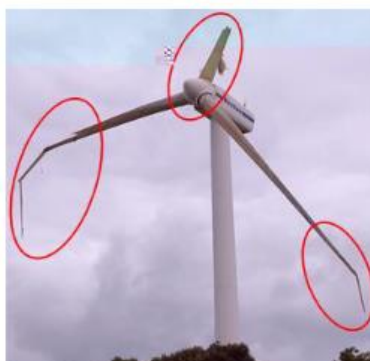
8号風車:ブレード3枚破損
